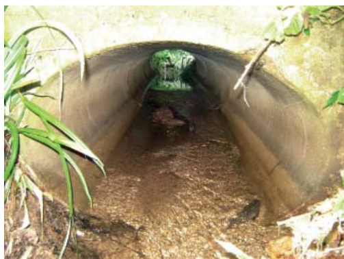
Pont permanent - CRPF - ER
