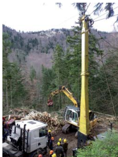
Cable-mât - CRPF - ER
